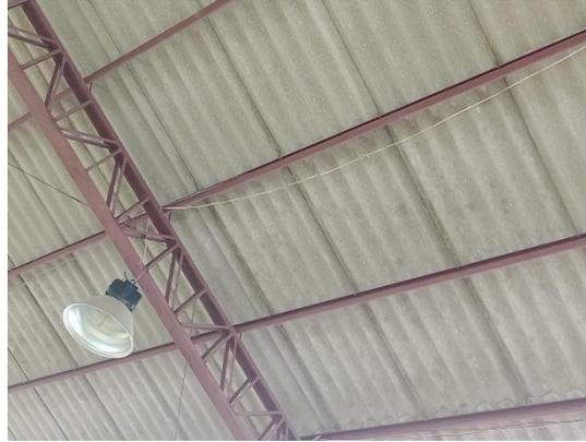
**Figura 16 Cableado sin protección en las vigas del coliseo.**
