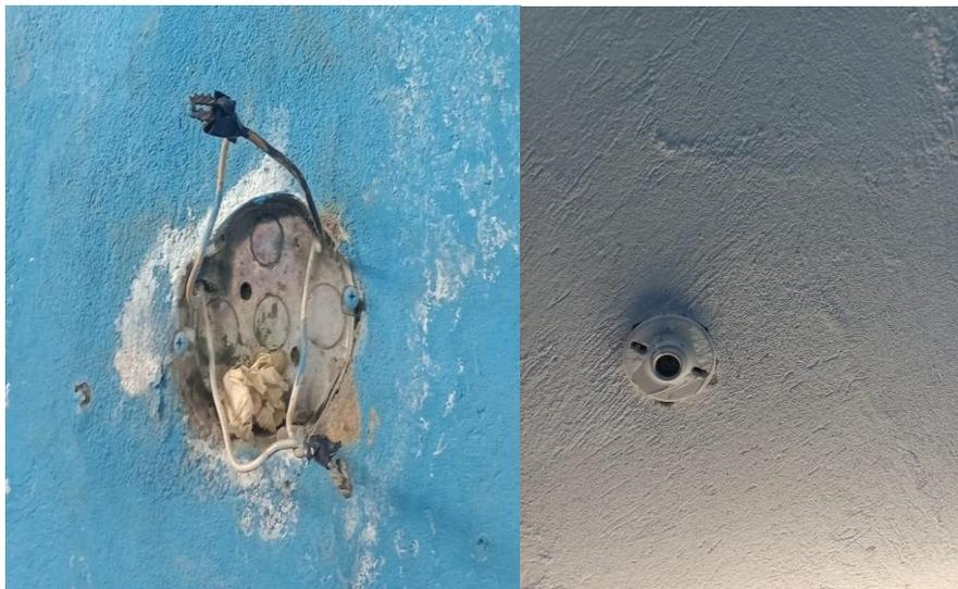
**Figura 47 Boquillas añadidas o reemplazadas en los vestuarios.**
