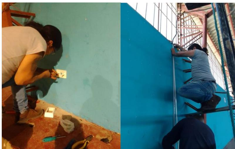
**Figura 40 Instalación de nuevos tomacorrientes en el coliseo**
