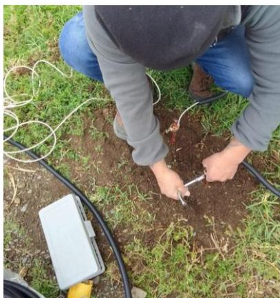
**Figura 41 Instalación de tierra**
