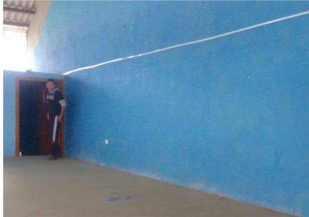
**Figura 43 Protección de cableado en vestidores.**
