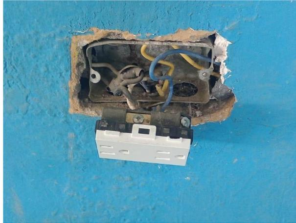
**Figura 19 Deterioro de tomacorrientes.**
