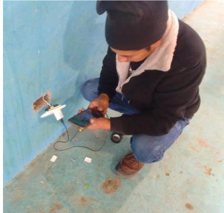
**Figura 59 Comprobación del funcionamiento de los tomacorrientes con un aparato sencillo, en este caso un cargador de celular.**
