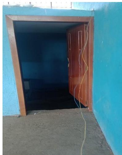
**Figura 15 Cableado a nivel de suelo en la entrada a vestidores del coliseo.**
