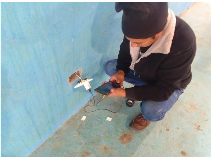
**Anexo O: Prueba del nuevo cableado con su respectiva manguera ya situado en la estructura del techo del coliseo.**
