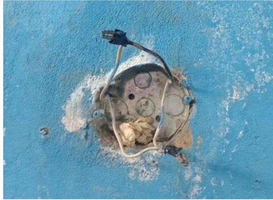
**Figura 17 Ausencia de boquillas para la iluminación.**
