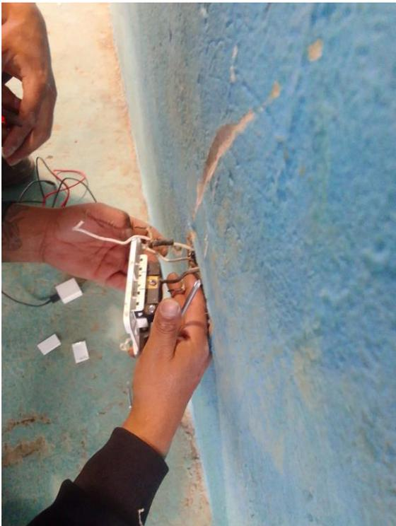
**Anexo H: Implementación del paso de cable en las mangueras corrugadas para los nuevos circuitos de las luminarias a implementar**
