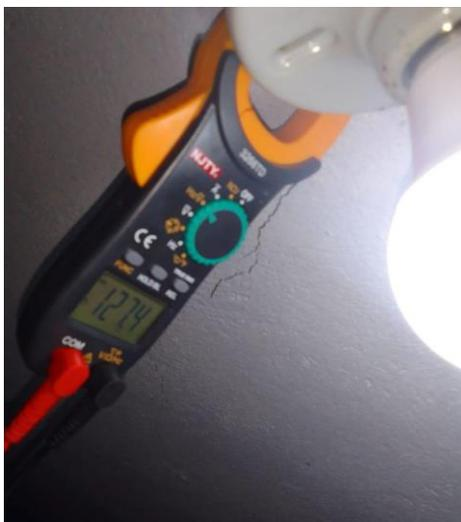
**Figura 50 Medición del voltaje con el multímetro en luminaria al interior de los vestidores para asegurar la correcta instalación de los interruptores y de las mismas boquillas.**
