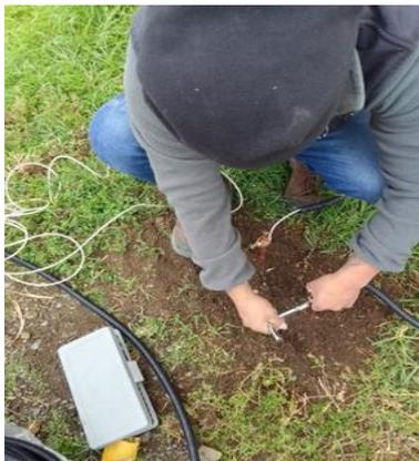
**Figura 53 Ubicación de la puesta a tierra y acceso a un correcto mantenimiento de la misma.**
