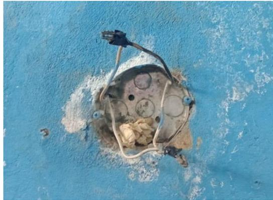
**Figura 28 Ausencia de boquillas para la iluminación.**
