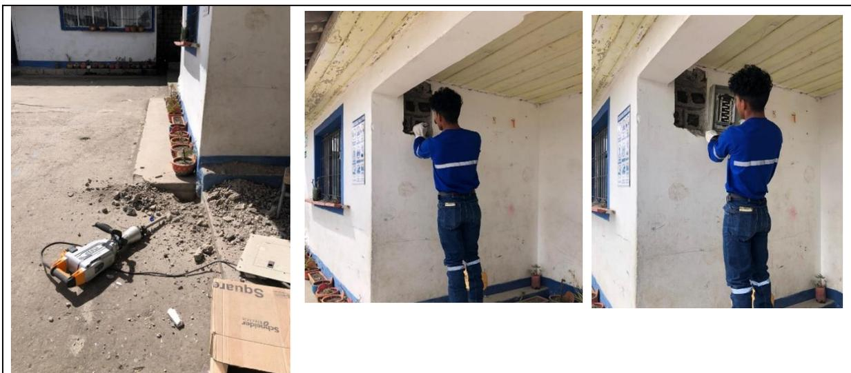
Figura 3.108. Perforación de la puesta a tierra. Preparación del espacio para el tablero principal.
