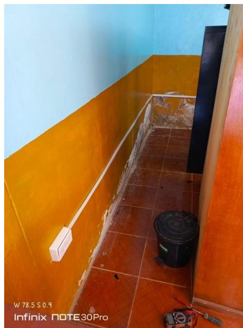
Figura 3.71. Cableado asegurado en canaletas.
