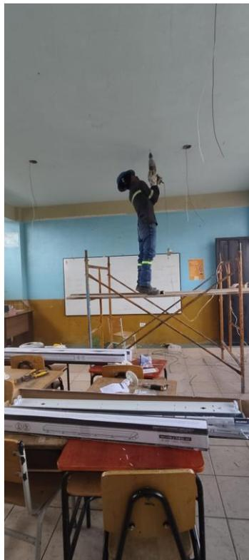
Figura 3.104. Perforación para puntos de sujeción.
