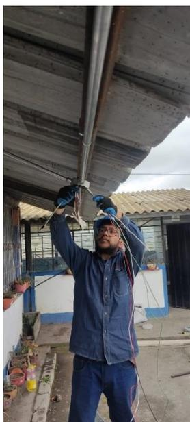
Figura 3.66. Ingreso de cableado a la dirección.
