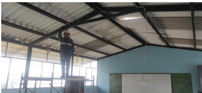
Figura 3.58. Tubería de luminarias
