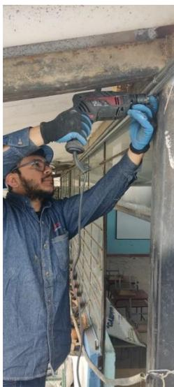
Figura 3.57. Fijación de la tubería.
