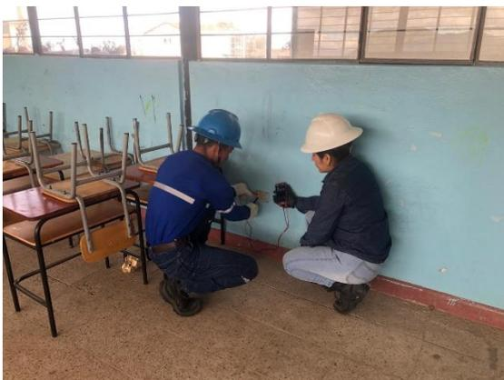
Figura 3.53. Comprobación de voltaje.
