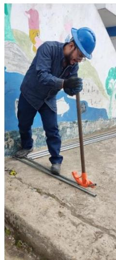
Figura 3.86. Doblado de tubería.
