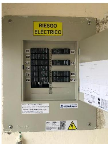
Figura 3.111. Termomagnéticos por circuito.
