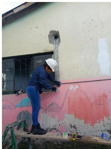
Figura 3.93. Ajuste de cajetín para exteriores.
