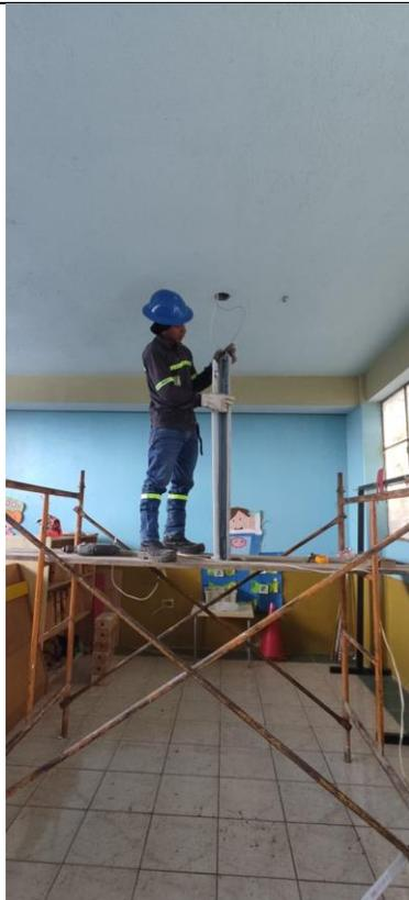
Figura 3.99. Conexión de luminarias.
