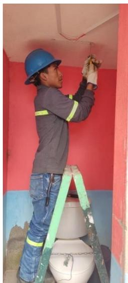
Figura 3.84. Instalación de luminaria.
