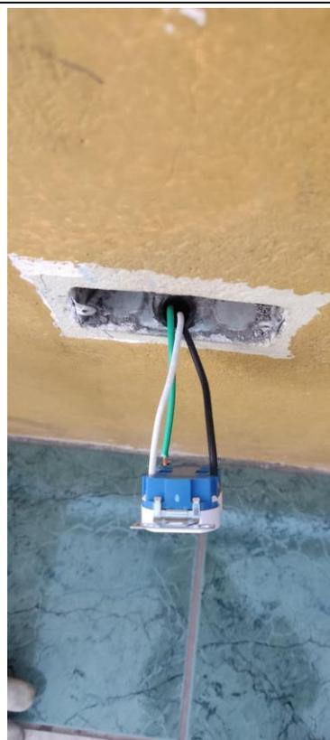
Figura 3.100. Identificación de cableado de fuerza.
