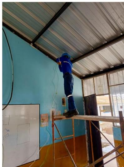
Figura 3.49. Nuevo cableado para luminarias.
