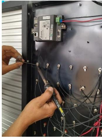
*Figura 44. Soldadura con estaño
