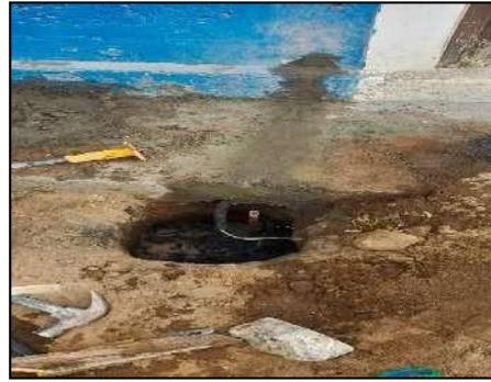
6.-Procedemos a conectar el cable con el de conexión a la varilla de tierra.
