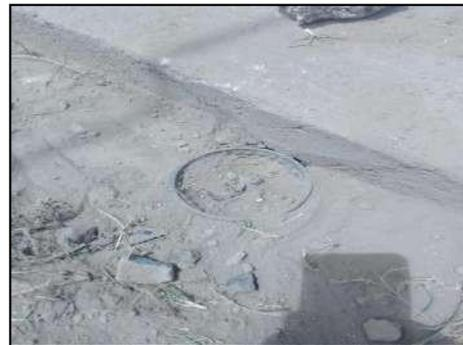
Ilustración 94: Conexión de la varilla de tierra
