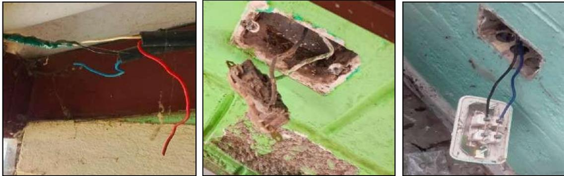
Ilustración 67: Tomacorriente e interruptore en mal estado
