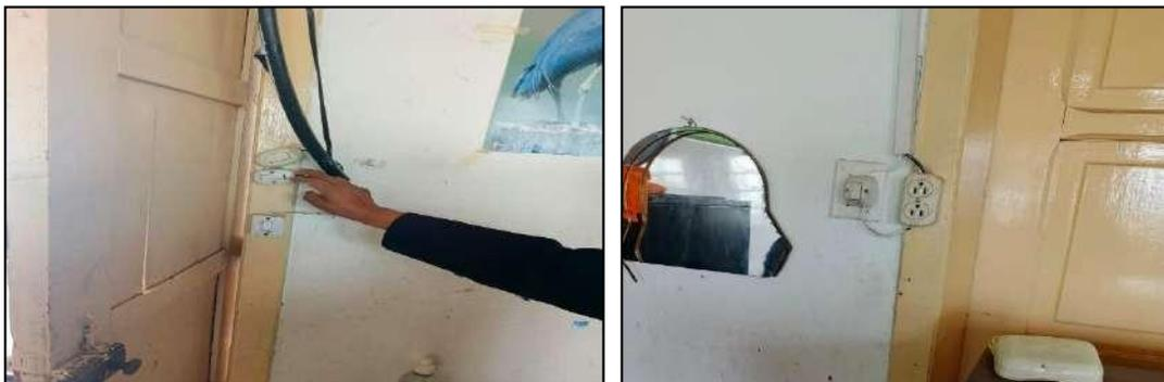
Ilustración 88: Tomacorriente mixto e interruptor triple a cambiar Aula # 6
