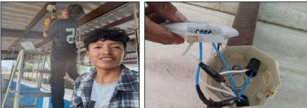
Ilustración 77: Sensores de movimiento
