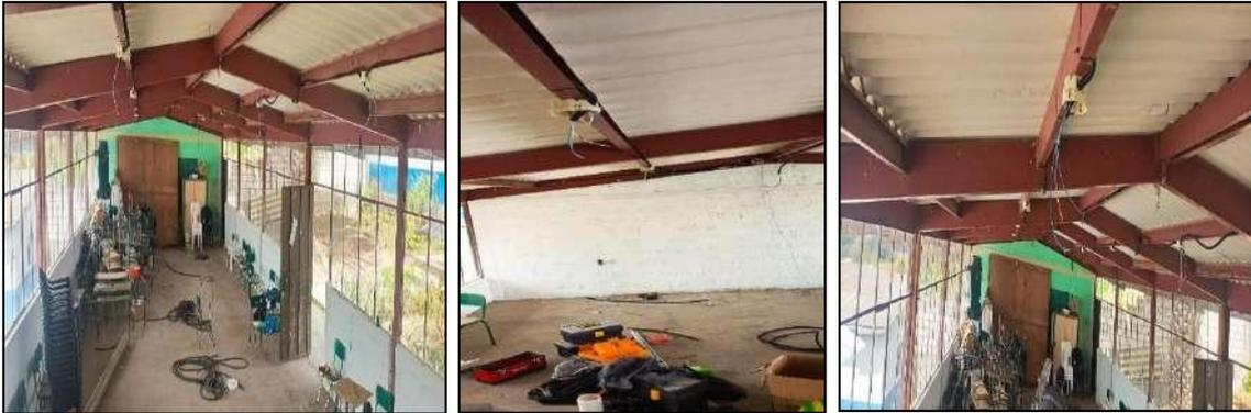
Ilustración 70: Cableado eléctrico Aula # 1
