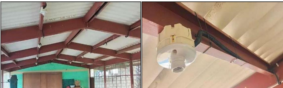
Ilustración 72: Colocación de boquillas
