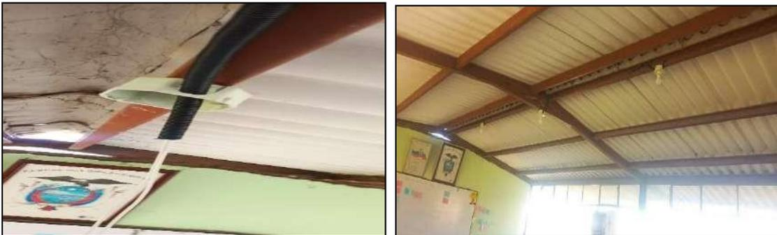
Ilustración 82: Colocación de boquillas y focos Aula # 4
