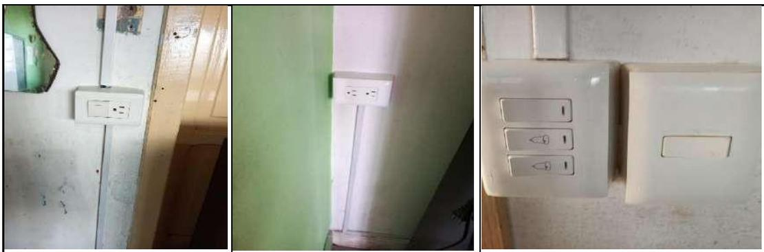
Ilustración 92: Tomacorriente mixto e interruptor triple cambiado en el Aula # 6
