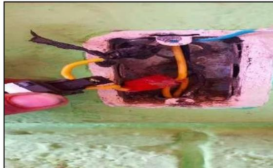
Ilustración 84: Tomacorriente e interruptor a cambiar Aula # 5
