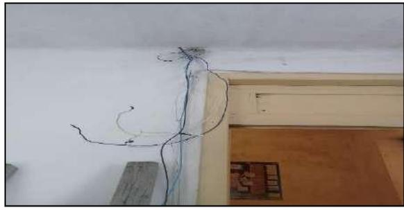
Ilustración 89: Cableado en mal estado Aula # 6
