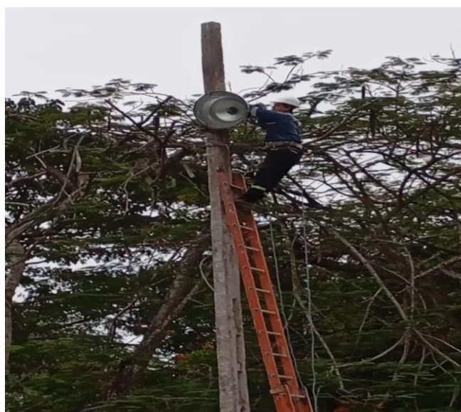
Figura 33 Colocación de los reflectores
