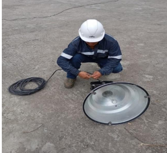
Figura 34 Montaje del conductor concéntrico
