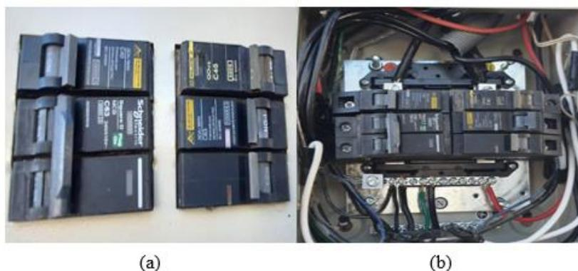
Figura 13. Centro de carga con tapa frontal (a) e interior (b)
