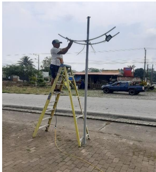
Figura 63. Instalación de las luminarias
