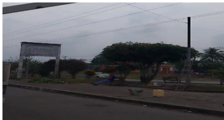
Figura 47. Acometida energizada hacia la caja de distribución
