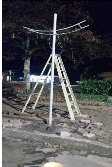
Figura 66. Vista de postes instalados
