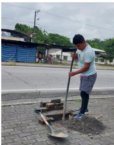
Figura 61, Preparación del terreno
