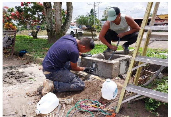
Figura 53. Instalación del tomacorriente para exteriores con protección IP44
