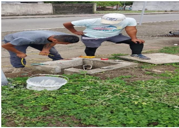
Figura 48. Instalación de caja de revisión
