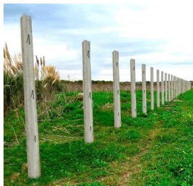
Figura 20. Poste de concreto
