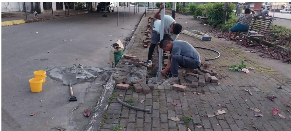
Figura 65. Instalación de los postes
