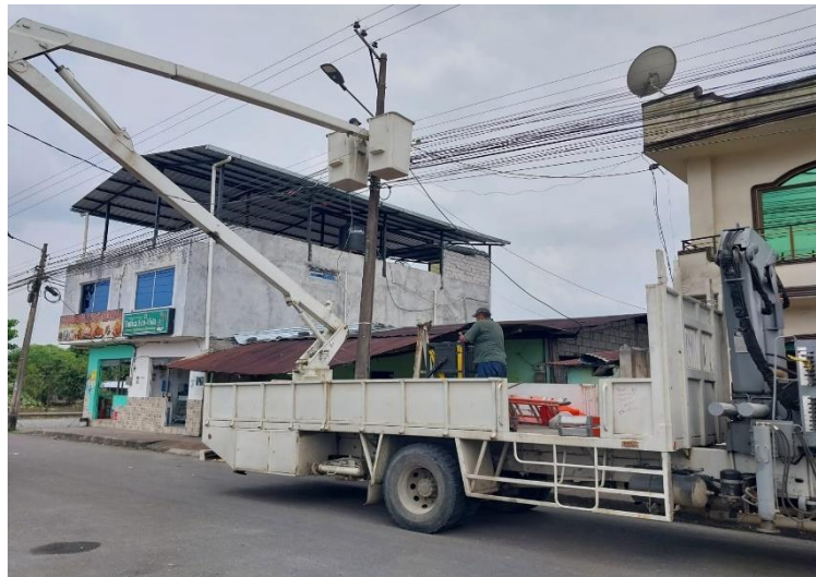
Figura 46. Instalación de acometida por parte de CNEL EP
