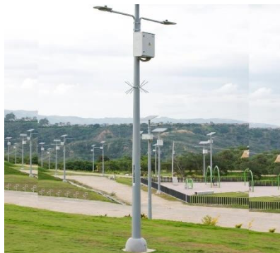
Figura 18. Poste de fibra de vidrio
