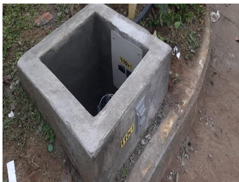
Figura 56. Caja de revisión terminada
