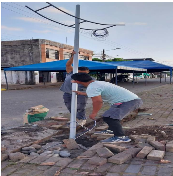
Figura 44. Instalación de nuevos postes
