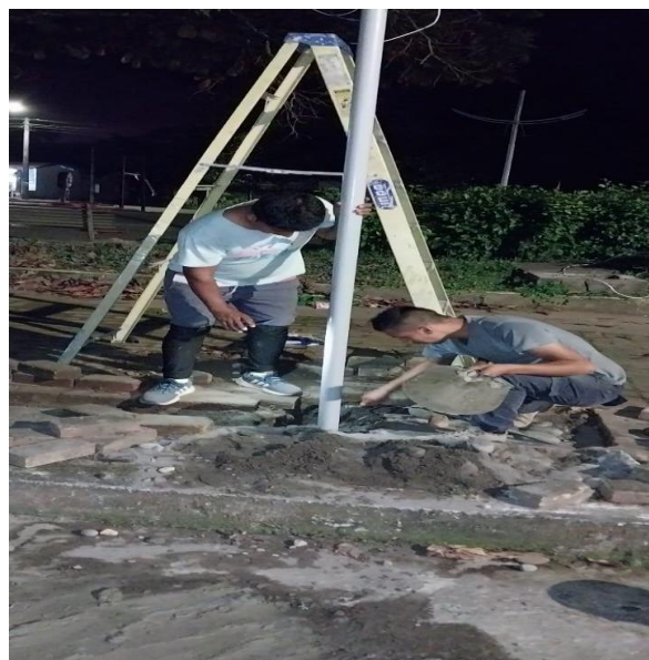
Figura 45. Culminado la instalación de los postes de nuevo diseño
