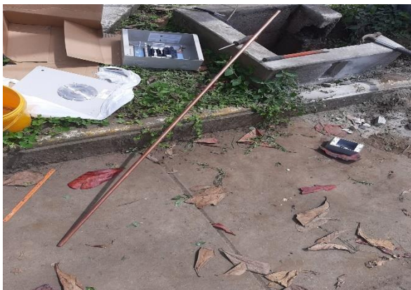
Figura 52. Instalación de la protección de la caja térmica instalación de una varilla en cada caja de revisión copperweld de 5/8" x 1.80m
