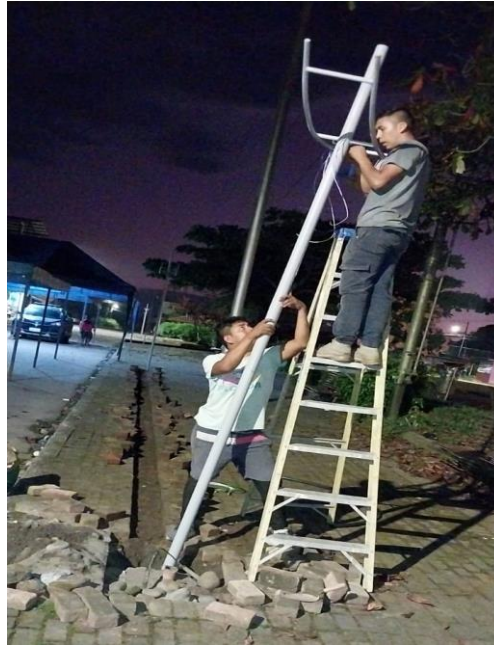
Figura 64. Montaje de los conductores para las luminarias
