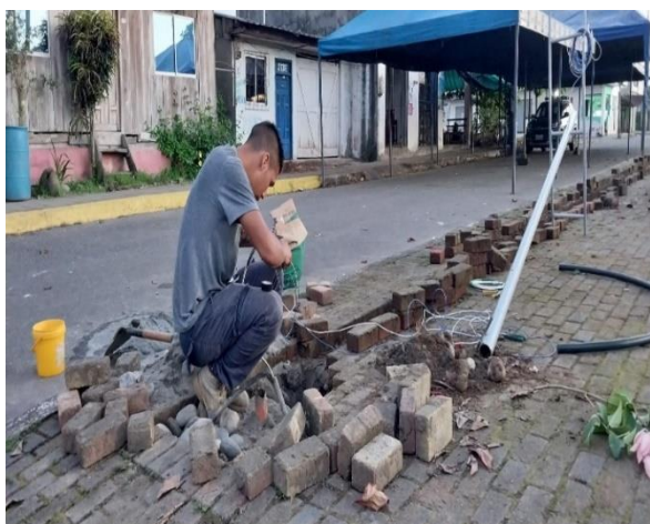
Figura 42. Instalación del nuevo cableado soterrado
