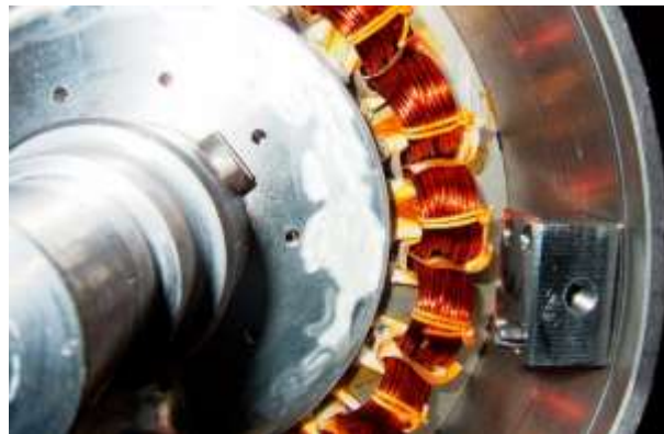
Fig. 13 medición de resistencia de aislamiento de un motor
