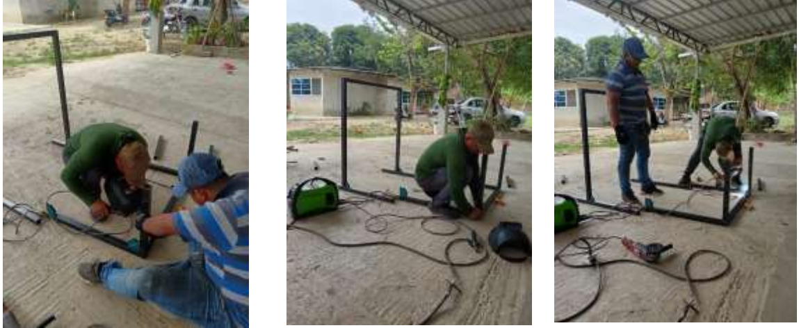
Fig. 20 Armado y soldadura de la estructura metálica
