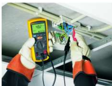
Fig. 16 Comprobación de la resistencia Megger Fluke 1507
