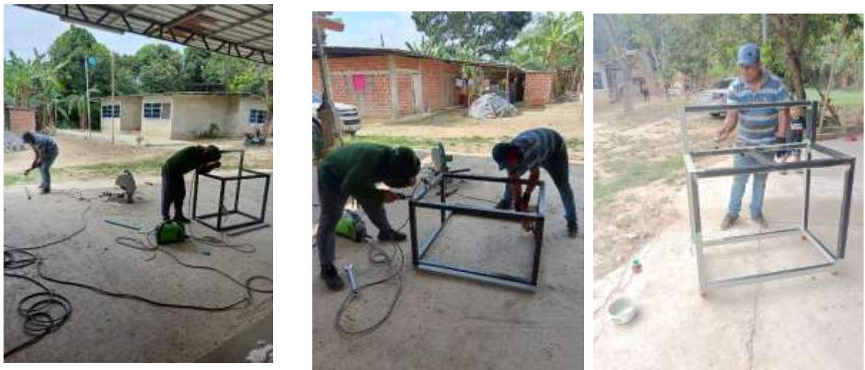
Fig. 21. Corrección de fallas y pintado de estructura
