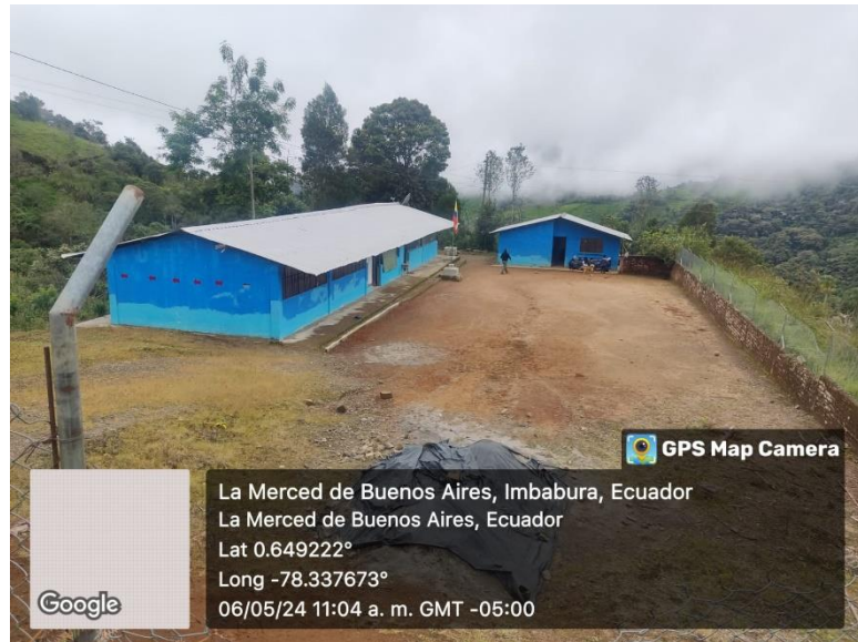
Figura 1. Infraestructura de la escuela "Buenos Aires el Porvenir".
