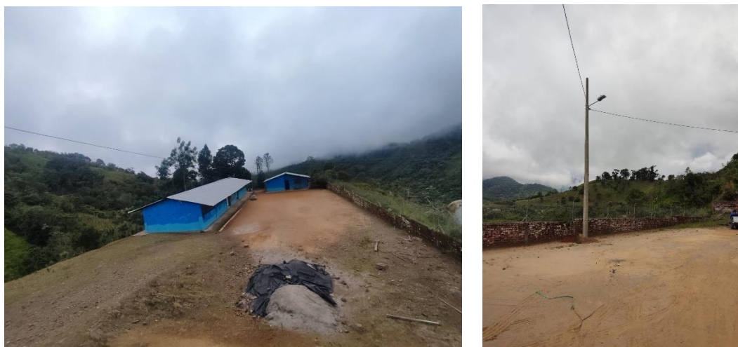
Figura 48. Instalación de iluminación exterior
