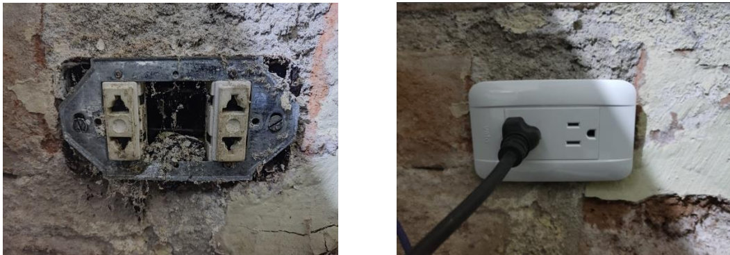
Figura 46. Mantenimiento a tomacorrientes de la institución.
