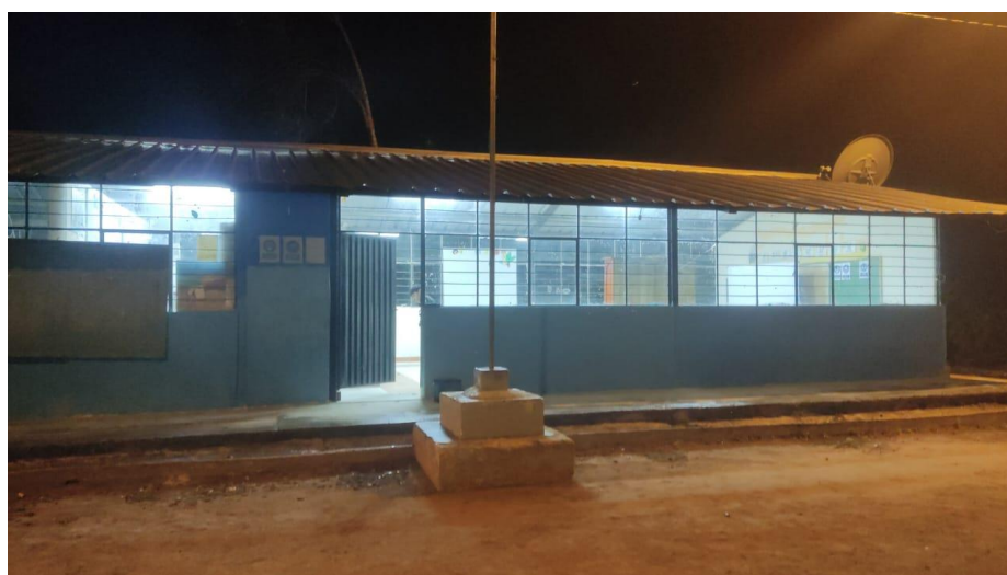
Figura 49. Implementación de circuitos de iluminación
