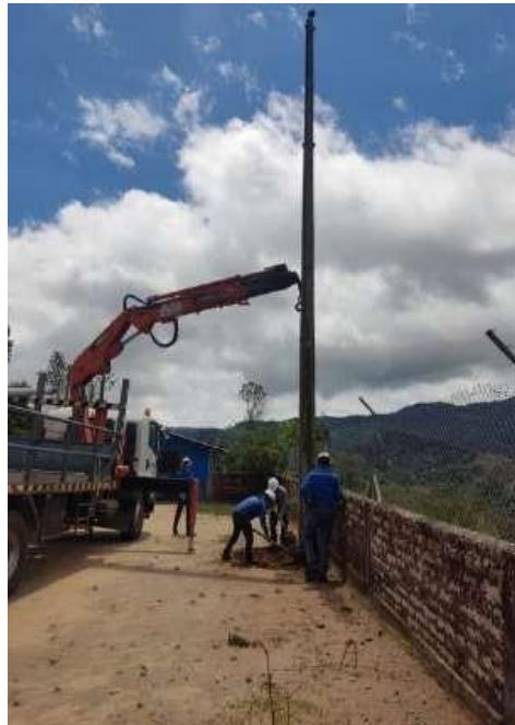
Instalación de la luminaria exterior
