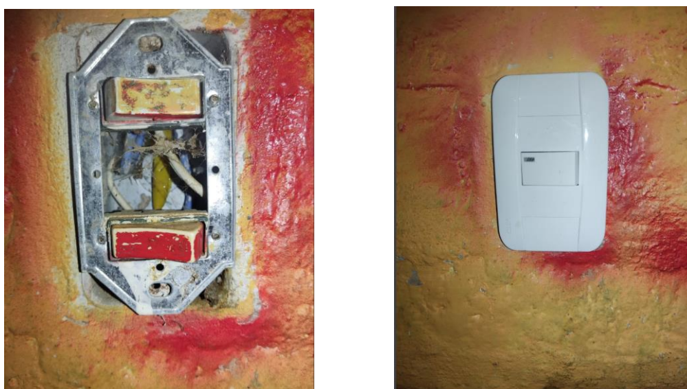
Figura 45. Cambio de interruptores
