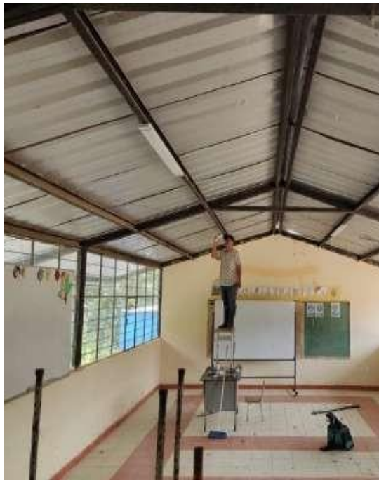
Cambio de luces internas de las aulas
