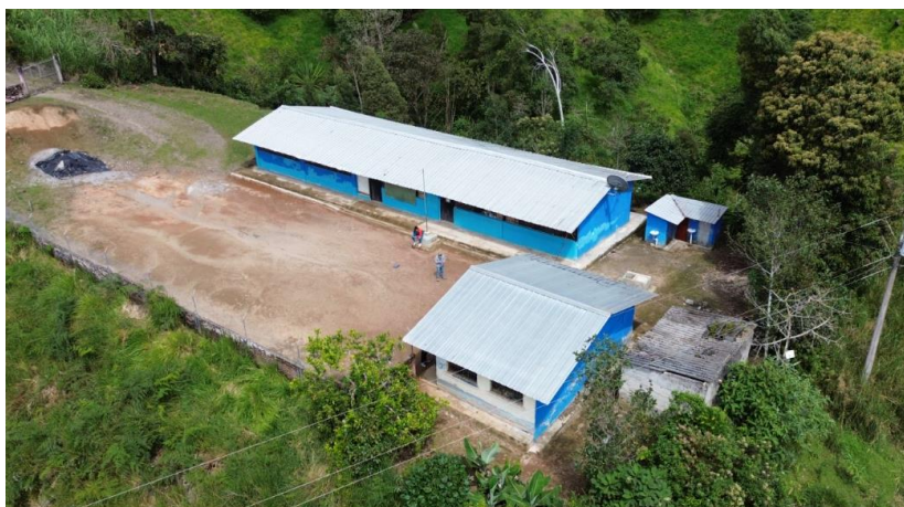
Figura 16. Carencia de iluminación externa.
