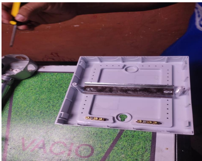
Figura 17. Colocación de barras
