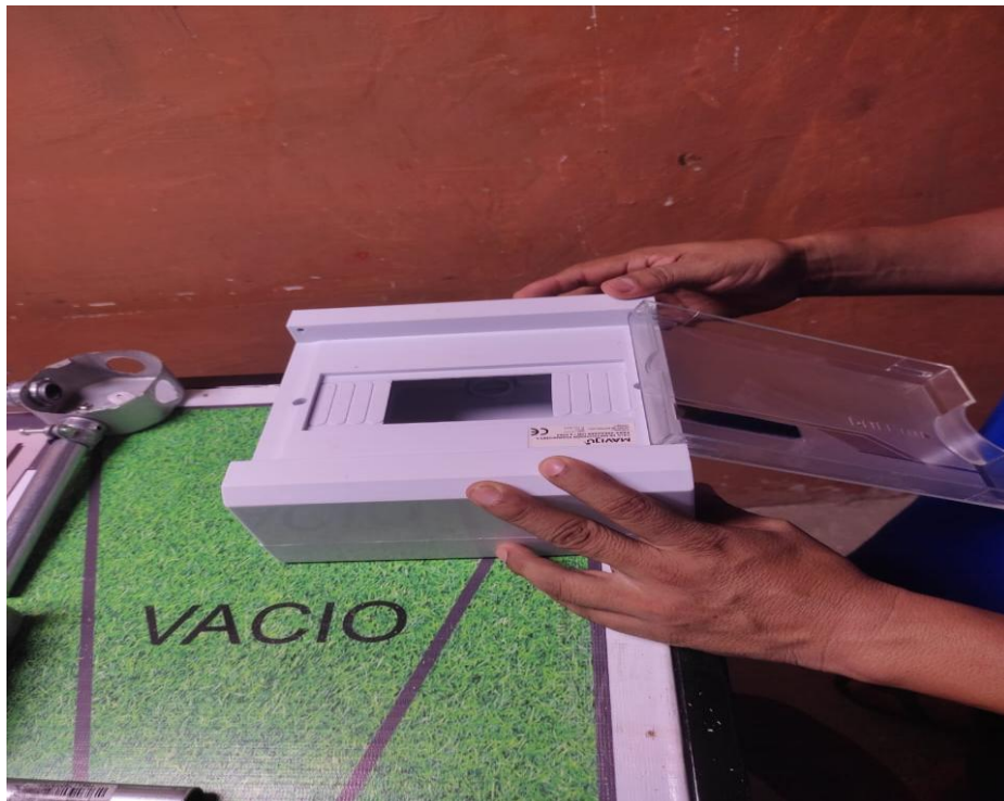
Figura 16. Instalación de las cajas
