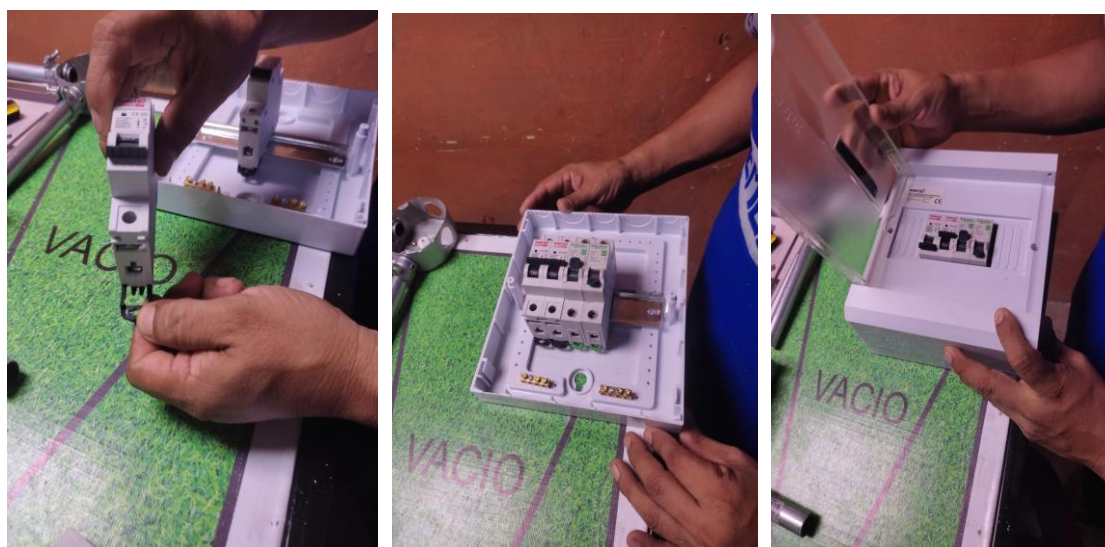
Figura 18. Montaje de interruptores
